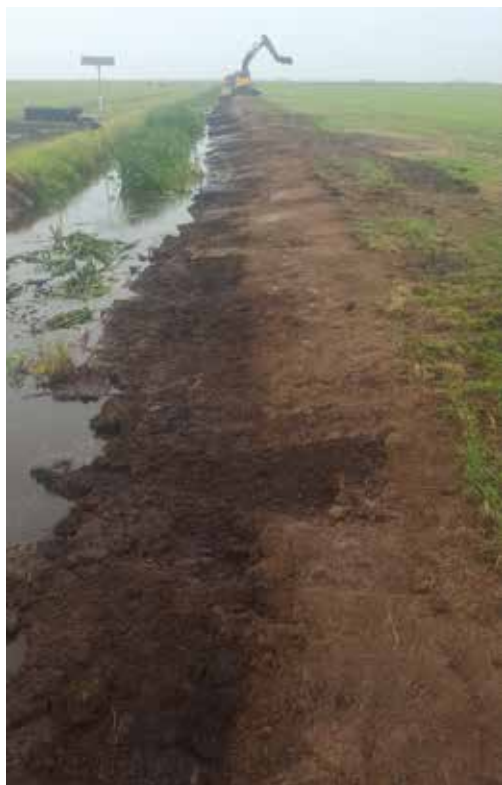
In totaal is ca 1 km sloottalud verflauwd.
